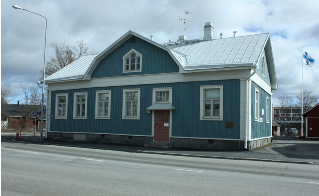
Rakennusta koskee suojelumääräys sr-1.
