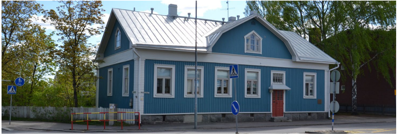
Kuva 9. Kuvassa Sininen talo, ent. Tenholan päiväkoti. Näkymä Tenholankadun ja Maaherrankadun risteyksestä.
